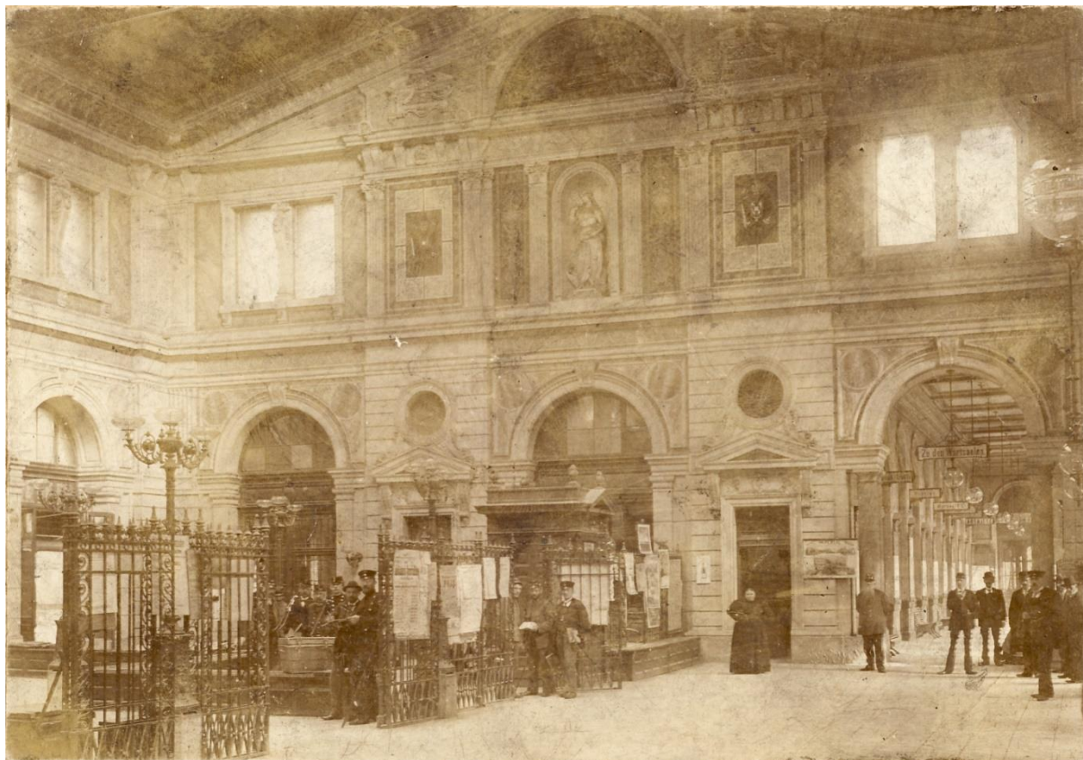
Obrázek 18: Interiér nádražní budovy Děčín-východ koncem 19. století
